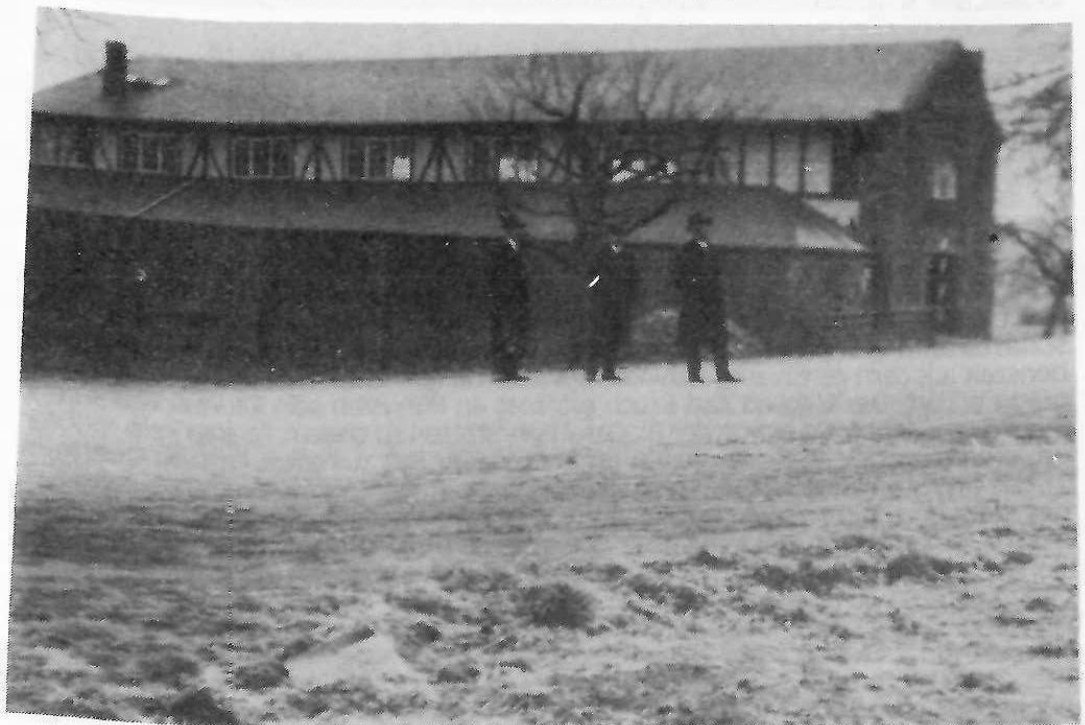
Der mühevolle Turnhallenbau wird von drei unbekannten Zeitgenossen nach Fertigstellung begutachtet (etwa 1923)
