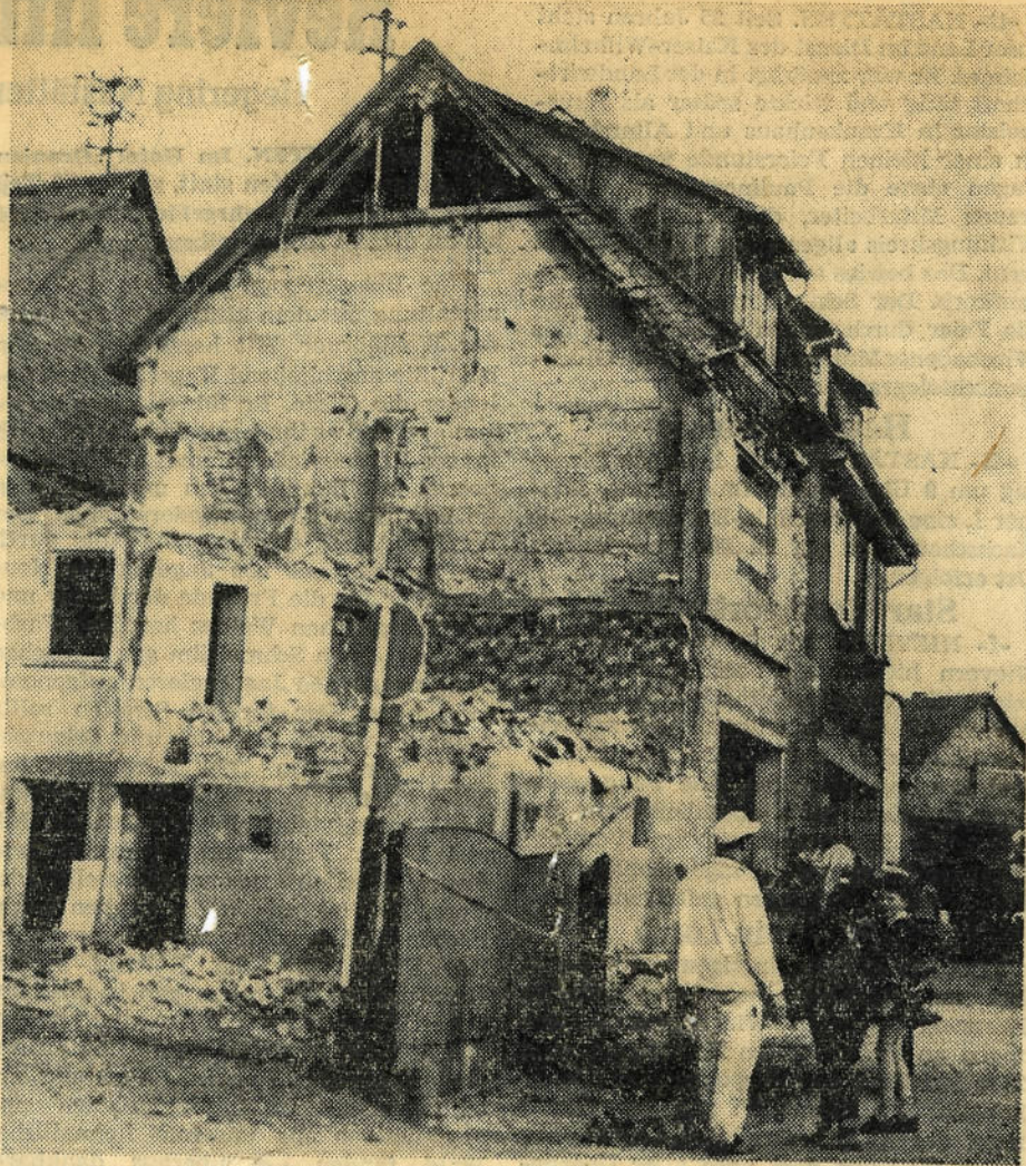
Fachwerkhaus verschwindet. An der Ecke Paul-Spindler-Straße/Friedhofs- weg wurde in diesen Tagen ein altes Wohnhaus abgebrochen, um Platz für ein neues zu schaffen. Die noch auf dem Bild zu sehenden Reste des Wohngeschosses und des Kellers sind inzwischen auch niedergelegt, und Nastätten ist um ein weiteres altnas- saisches Fachwerkhaus ärmer geworden.
