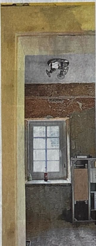
Vieles wird neu sein: Eine Behindertentoilette darf nicht fehlen.
